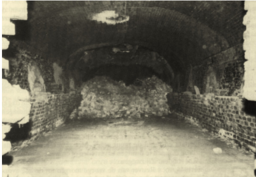
Gedeeltelijk afgebroken oven, binnenkant.
